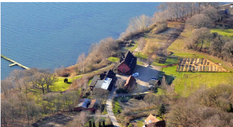
Eksisterende bebyggelse før branden.
